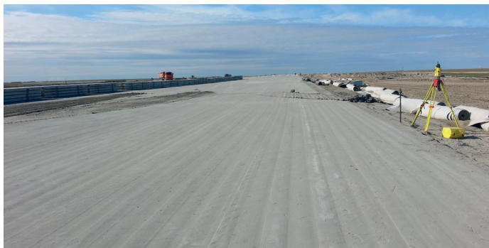
ЯНАО, п-в Ямал, аэропорт Сабетта, готовое основание аэродромной одежды ИВПП из укрепленного очень тонкого пылеватого песка
