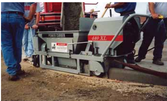
>>> Машина Power Curbers PC440-XL с двойным шнеком укладывает бордюр до 45,7 см в ширину и 30 см в высоту
